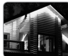
Заливка светом карнизов
